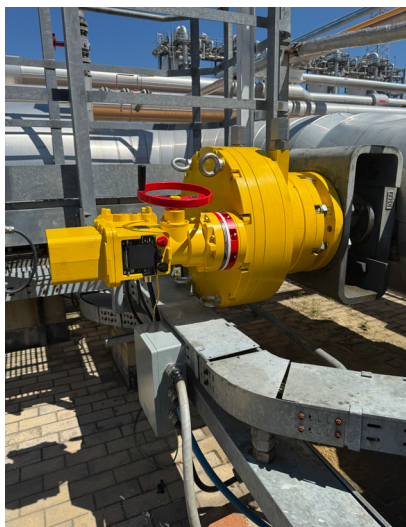
Электропривод РэмТЭК.П.63000.42 (крутящий момент – 63 тыс. Н·м, время перекрытия – 42 с) на поворотном затворе КС «Казачья» ООО «Газпром трансгаз Краснодар»
